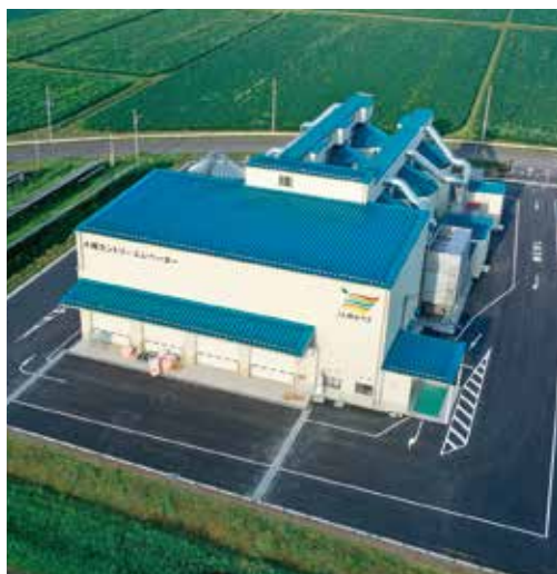
新しく建設した大郷カントリーエレベーター
