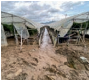
朝倉市杷木久喜宮のアスパラガスハウス
