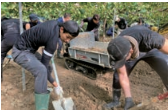
▲ブドウ園地の復旧作業(10月13日)
